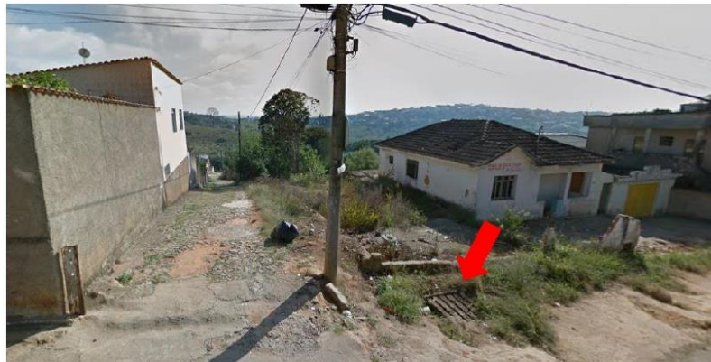
Figura 1 - Boca de lobo existente a Rua Frei Orlando Fonte: Google Maps
