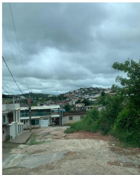
Figura 18 – Atual situação do trecho a ser pavimentado
